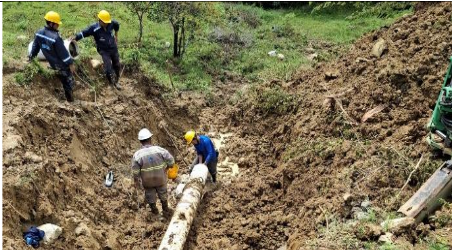
REPARACIÓN DE RED DE TUBERIA DE 12" - SECTOR CABAÑAS.
