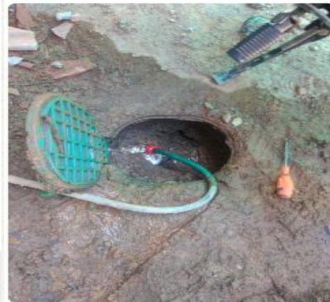
Construcción plaza hay que cortar con hidro 1604
