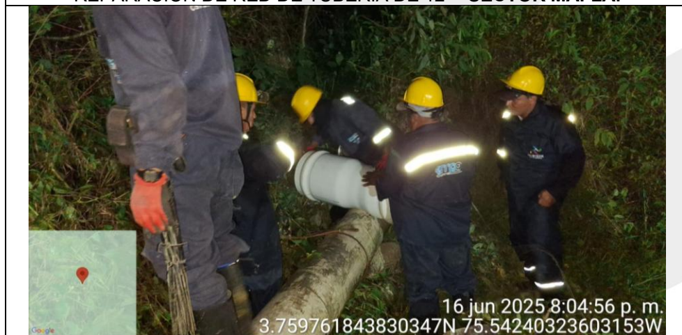
REPARACIÓN DE RED DE TUBERIA DE 12" - SECTOR MAFLA.
