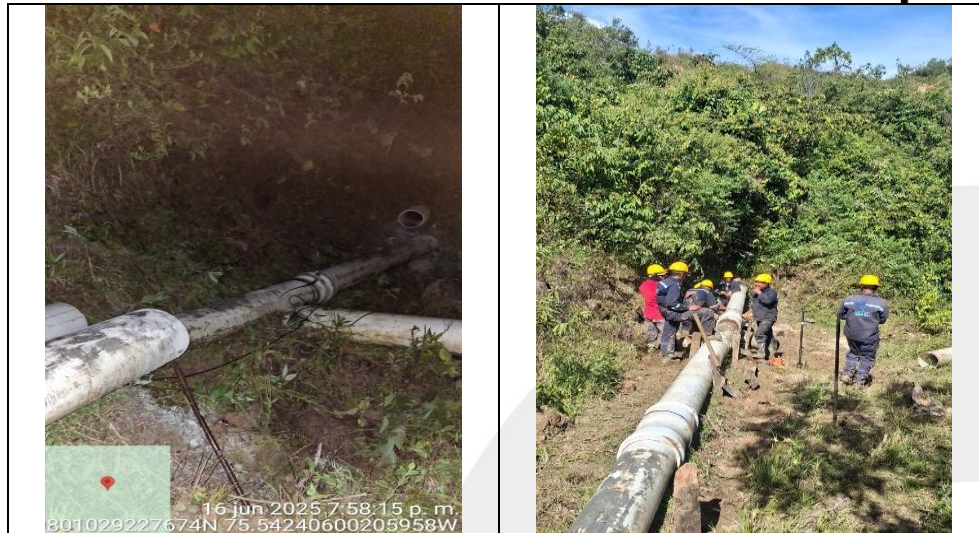
REPARACIÓN DE RED DE TUBERIA DE 12" - SECTOR MAFLA.
