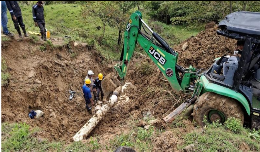
REPARACIÓN DE RED DE TUBERIA DE 12" - SECTOR CABAÑAS.
