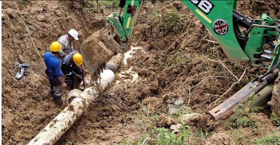
REPARACIÓN DE RED DE TUBERIA DE 12" - SECTOR CABAÑAS.
