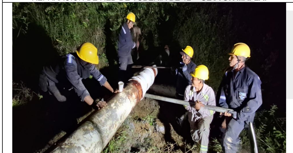
REPARACIÓN DE RED DE TUBERIA DE 12" - SECTOR MAFLA.
